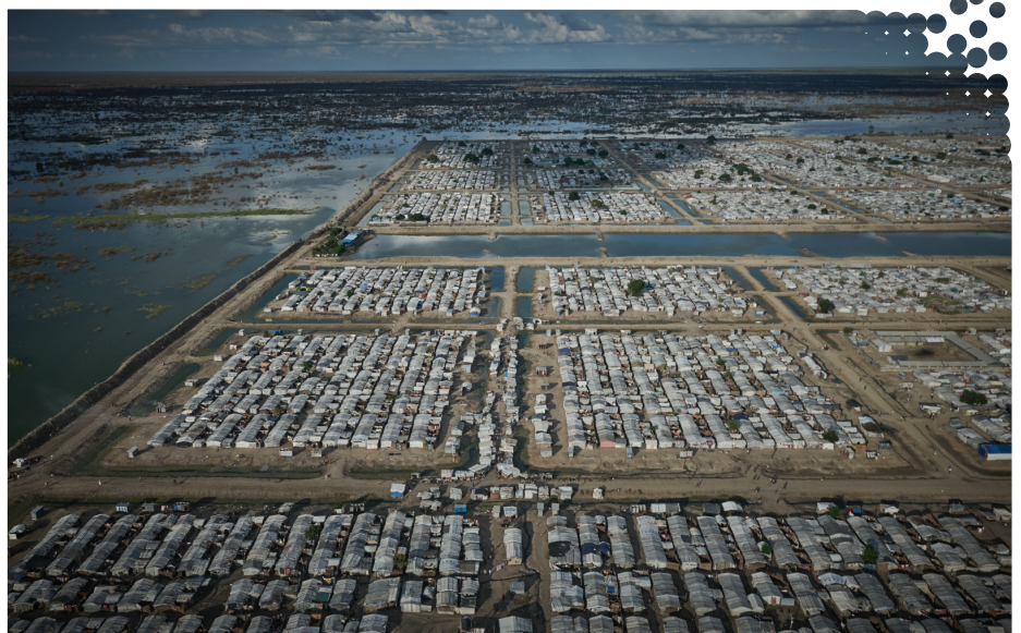
南スーダンのベンティウに所在する国内避難民キャンプの航空写真。約12万人が居住するキャンプ地を洪水が囲んでおり、キャンプを守っているのは土手のみです。グローバルファンドは南スーダン国内で移動を余儀なくされ、「文民保護区」で暮らす人々を対象としたエイズ関連プログラムを支援しています。
